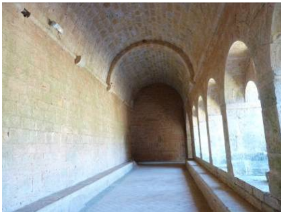
Galerie sud du cloître
