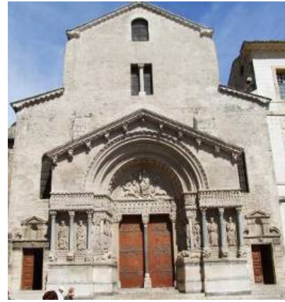
Façade église Saint-Trophime – Arles
