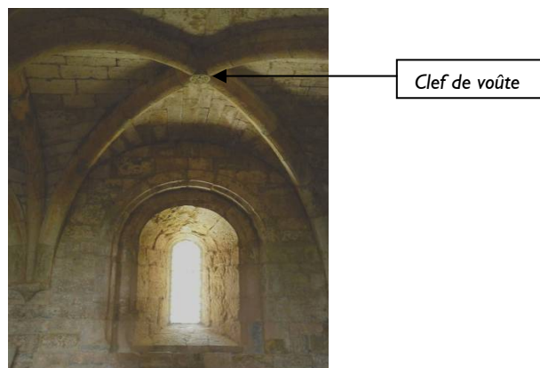
Voûte sur croisée d'ogives - Salle capitulaire
